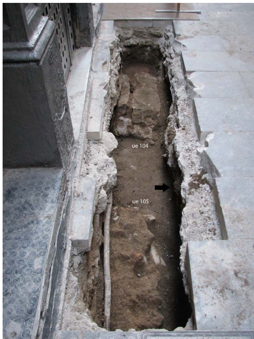
Mur (ue 105) i claveguera (ue 104)
